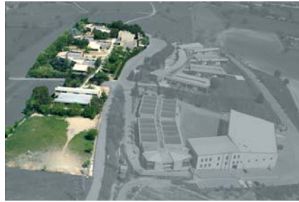
Instal·lacions del CEE Montserrat Montero (Foto: Jordi Pey)
