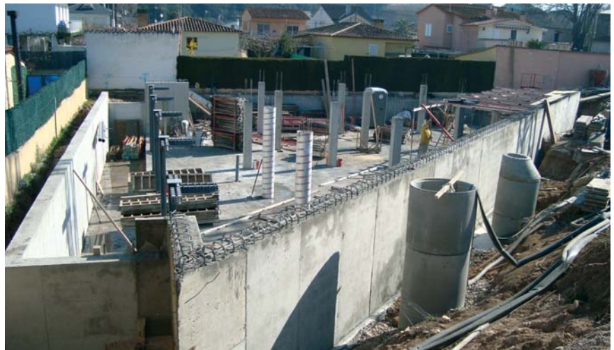
Les obres ja han començat el sostre del soterrani de la llar-residència
