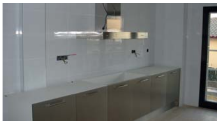
Detall de la cuina, amb els primers mobles i electrodomèstics instal·lats
