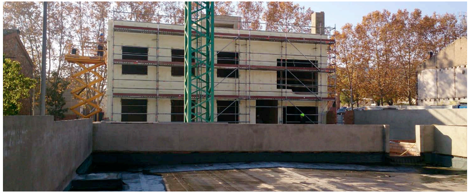
Les obres de la nova llar-residència de Granollers acabant l'any 2013
