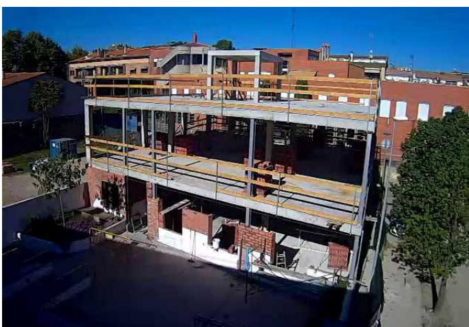
Evolució de les obres de la segona llar residència del complex situat a Granollers el darrer tram de l'any 2016.
