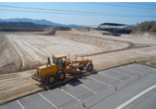
EL MOVIMENT DE TERRA DE ELS TRES PLATAFORMES JA ESTÀ FINALITZAT
