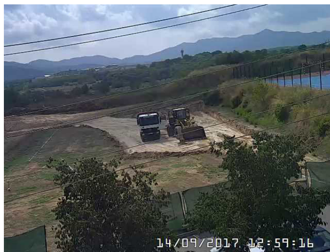
Inici de les obres de construcció del Centre de Rehabilitació Funcional
