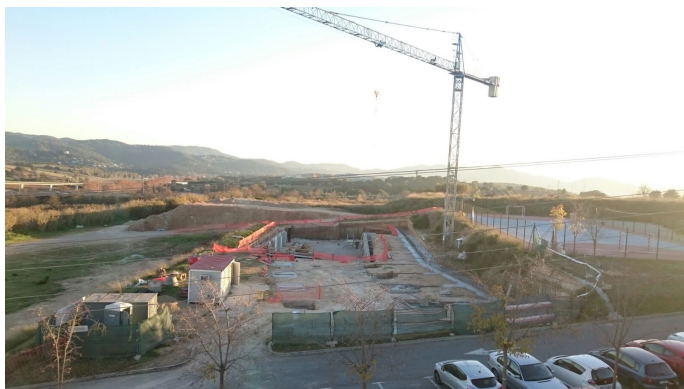
Les obres del futur Centre de Rehabilitació Funcional a desembre de 2017
